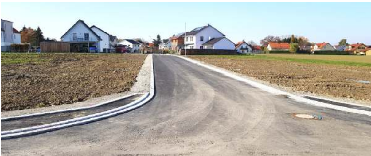
Bis auf die Asphaltfeinschicht ist die Erschließung abgeschlossen
